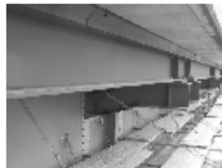
仮設縦桁及びブラケット設置状況▶ P.15
